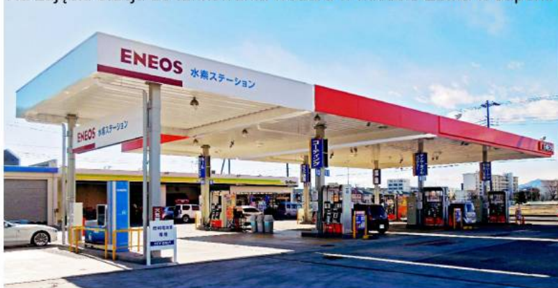
Na zdjęciu stacja do tankowania wodoru w mieście Ebina w Japonii
