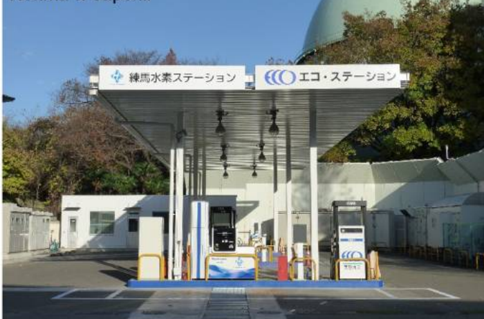
Na zdjęciu stacja do tankowania wodoru w mieście Nerima w Japonii
